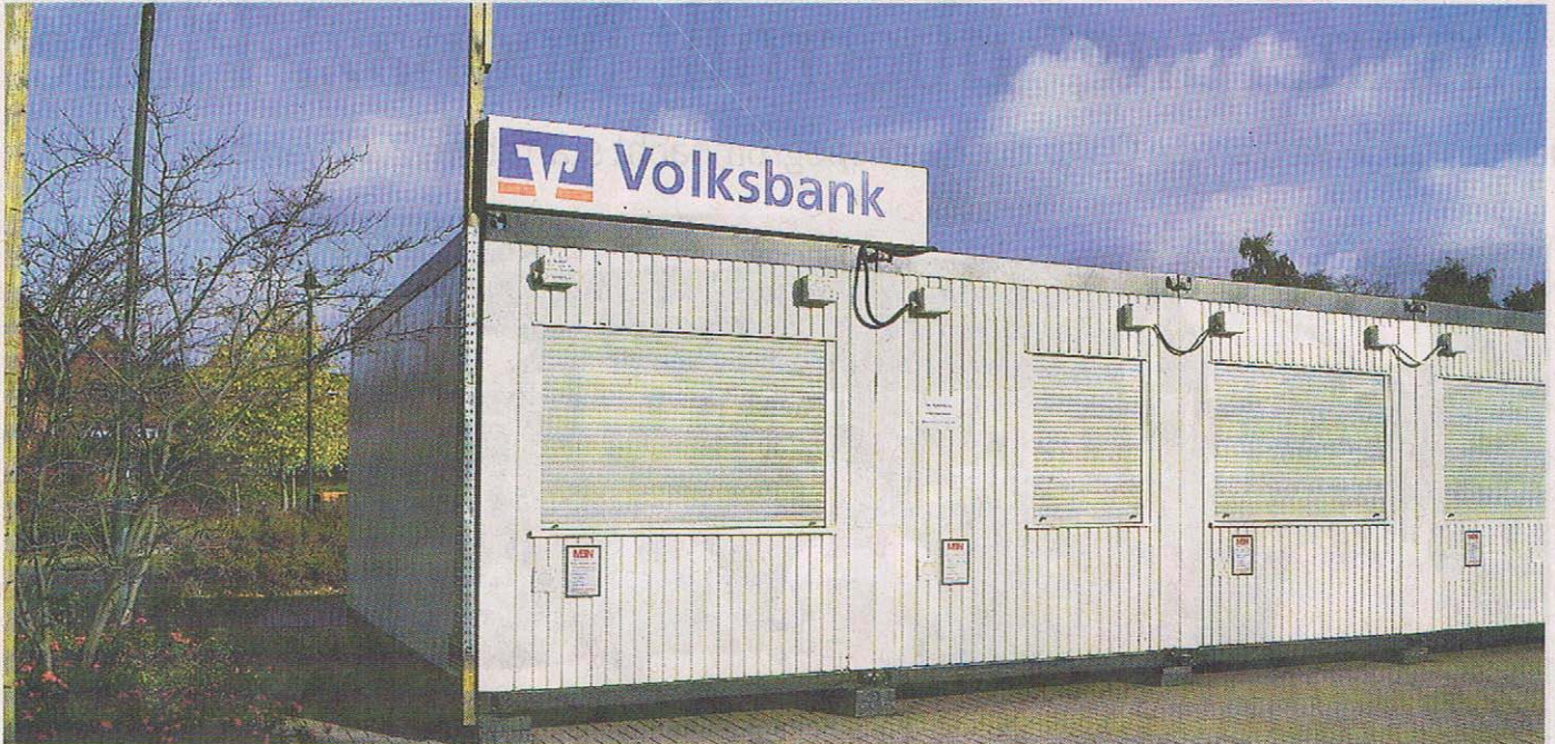
Ab Montag laufen die Volksbank-Geschäfte in Lauenau in einer Containeranlage.
